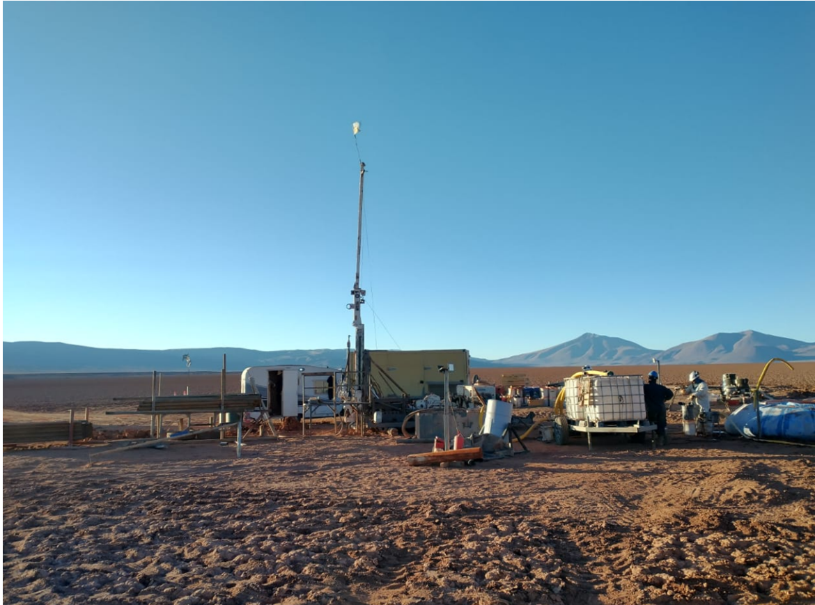
Drill Rig Set Pocitos 1, Pocitos Salar, Argentina
